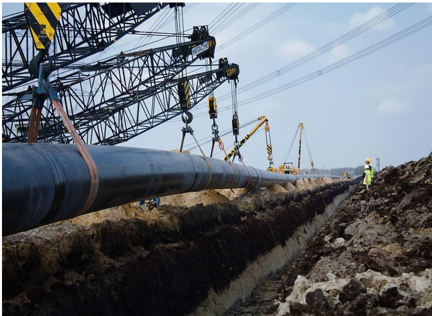
Fig. 13 Leiding aanleg plaatsen van een leidingstreng
