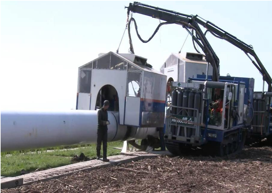
Fig. 12 Een lastrein voor het lassen van de leiding in aanleg.
